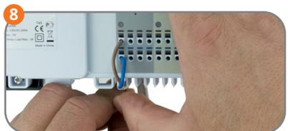
Empuje los cables del actuador en los orificios en la parte inferior de la extensión de cableado-RF. Puede conectar hasta cuatro actuadores en cada zona.
