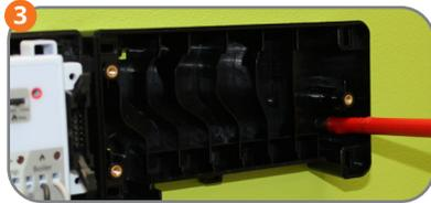
Conecte la parte posterior de la extensión de cableado Quantum RF al riel DIN o la pared. Si está ajustando a un lado, use el cable plano corto. De lo contrario, utilice el cable plano largo (consulte el paso 10). A continuación se muestra la instalación en pared de montaje lateral:
